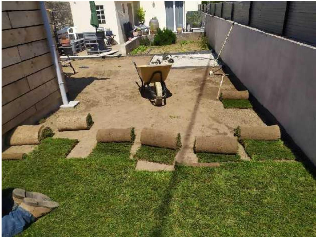
Sur des terrains en pente, le gazon est agrafé (avec des agrafes de type toile de paillage) Les agrafes doivent être suffisamment enfoncées pour ne pas gêner la tonte.
